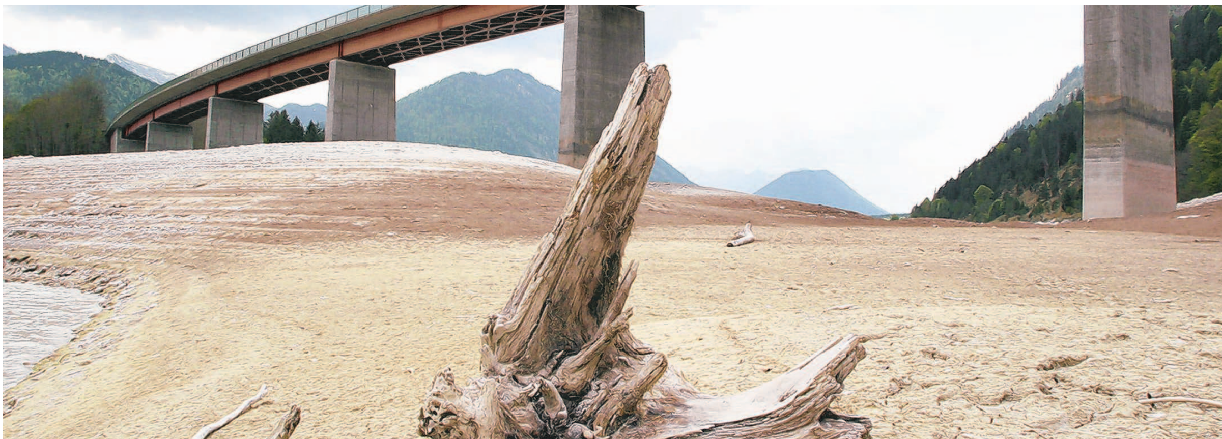
Dürre am Sylvensteinspeicher: Sand, Schlamm und wenig Wasser prägten dort vor einem Jahr das Bild. Am rechten Brückenpfeiler ist der Normalpegel zu erkennen.
