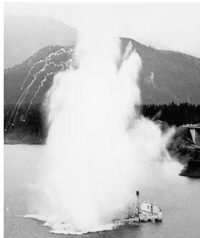
Eine Sprengladung versenkte im Mai 1959 das letzte Haus.
