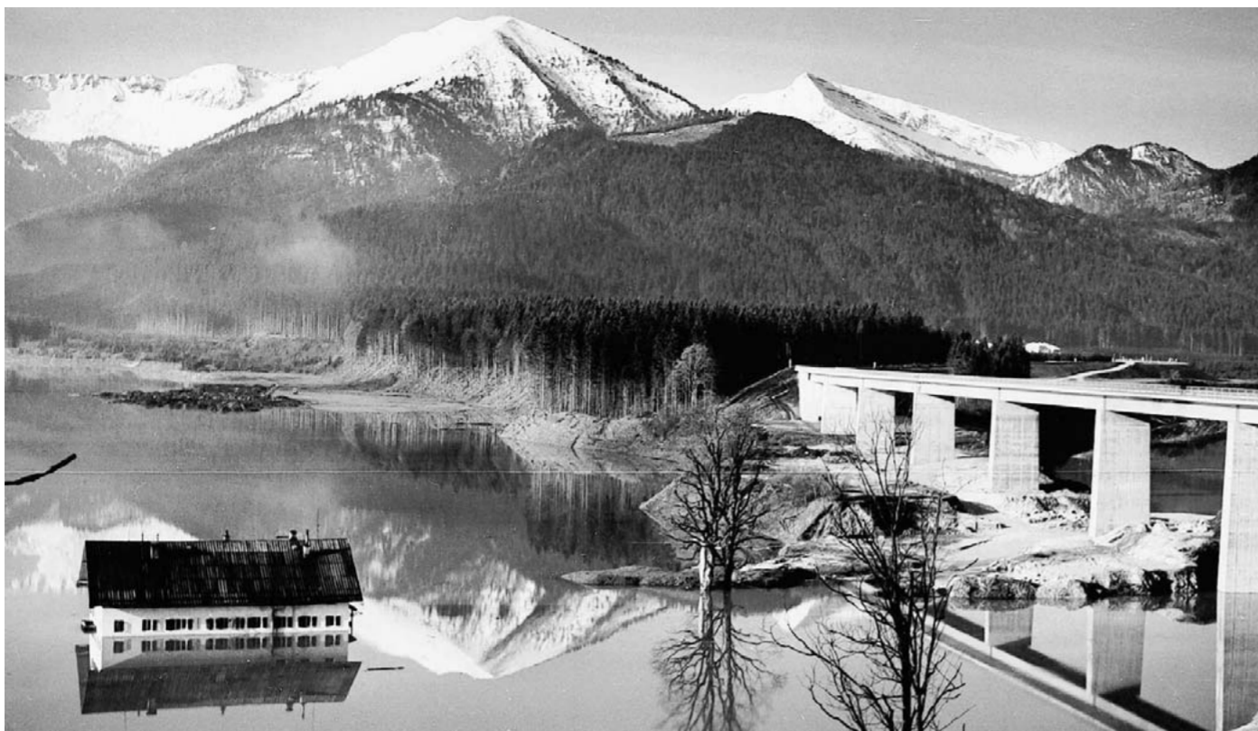
Das letzte Haus von Alt-Fall im bereits gefluteten Sylvensteinsee kurz vor der Sprengung.
